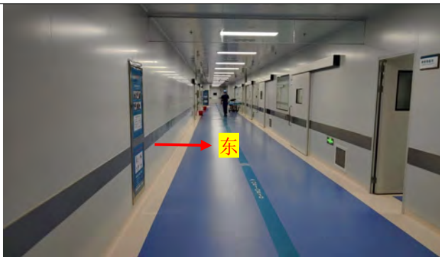
DSA 手术室东侧走廊
