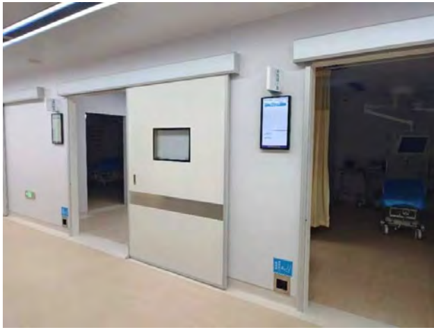
DSA 机房手术室楼下内窥中心
