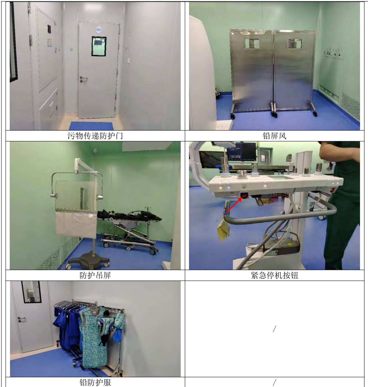
图 3-1 DSA 复合手术室辐射安全与防护措施现场照片（2024 年 3 月 15 日）
