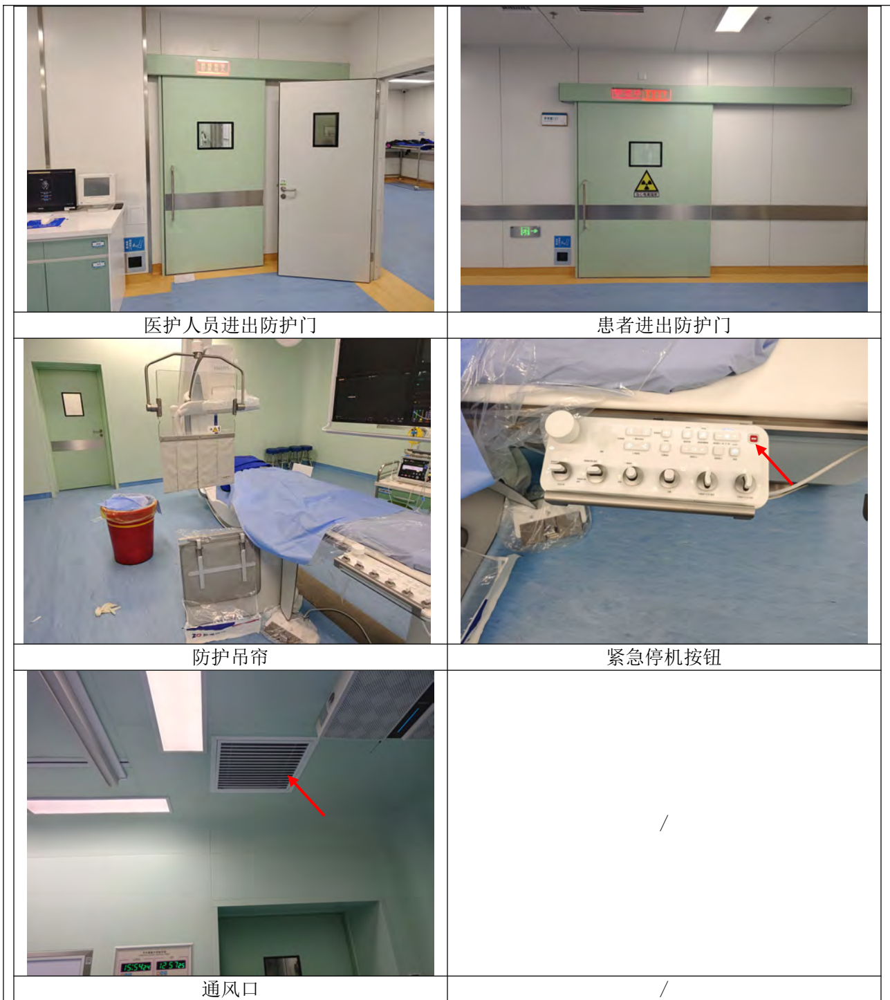
图 3-2 导管二室辐射安全与防护措施现场照片（2024 年 3 月 15 日）
