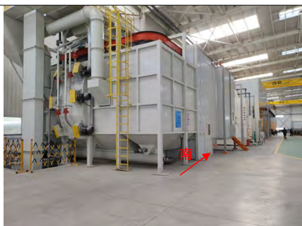
探伤室南侧（喷涂区）
