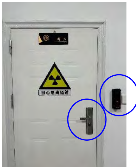
图 3-7 贮源库防护门双锁现状照片
