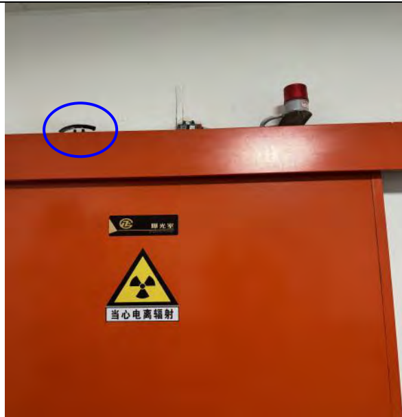
图 3-6 探伤室门-机连锁装置现状照片
