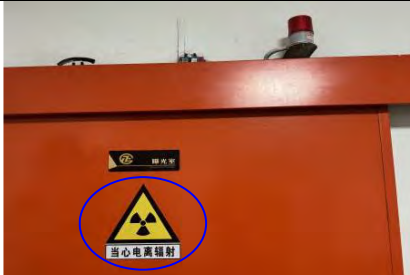
图 3-10 探伤室电离辐射警告标志现场照片
