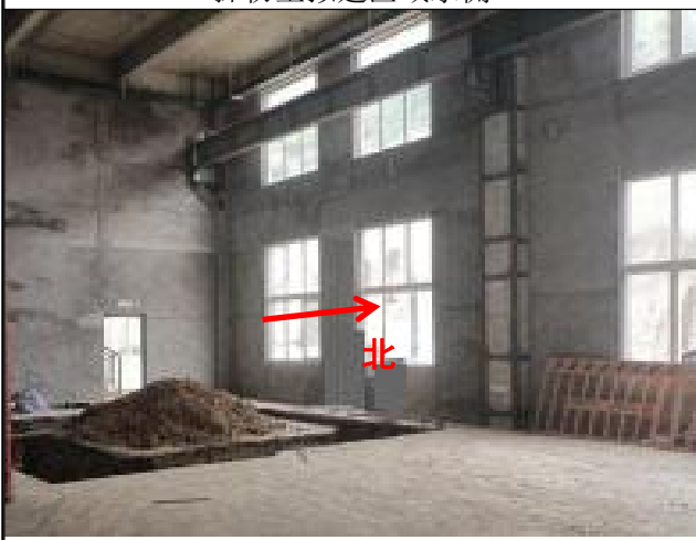
探伤室拟建区域北侧
