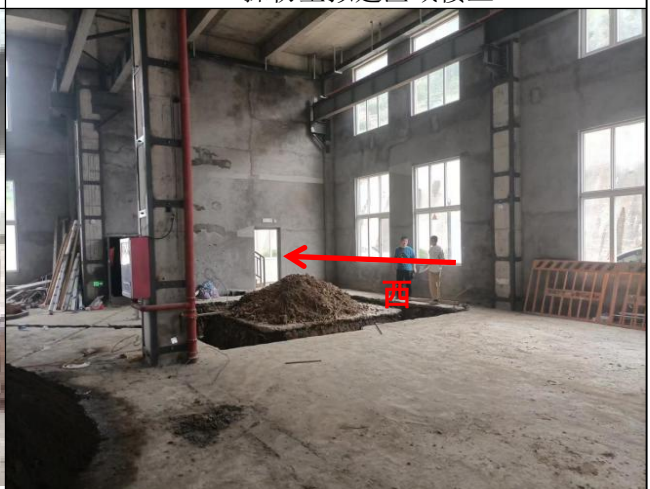
探伤室拟建区域西侧
