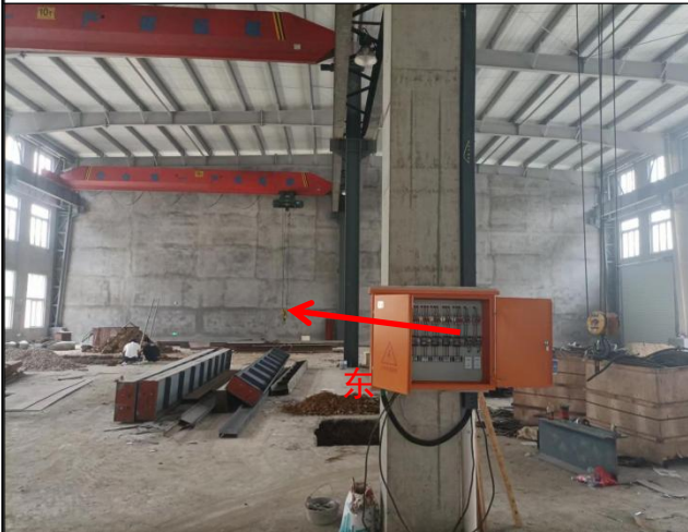
探伤室拟建区域东侧
