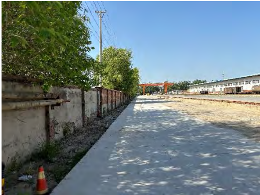
3. 电缆周围土地恢复情况
