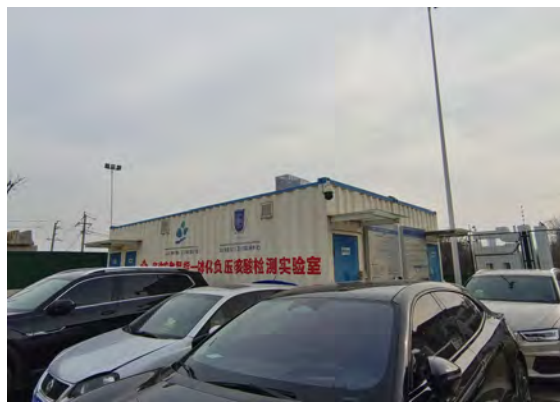
DSA 机房东北侧核酸检测实验室
