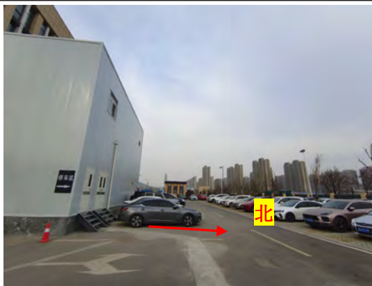
DSA 机房北侧院内道路
