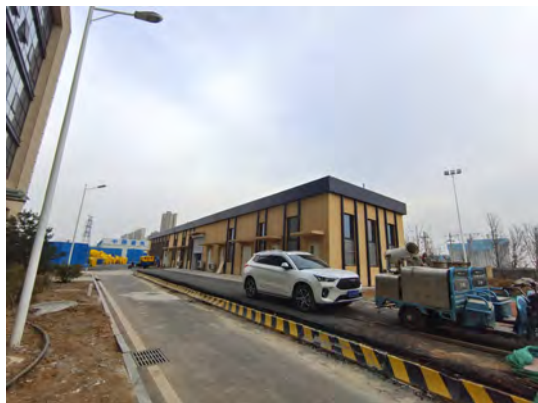
DSA 机房北侧医疗废物暂存间等医院辅房
