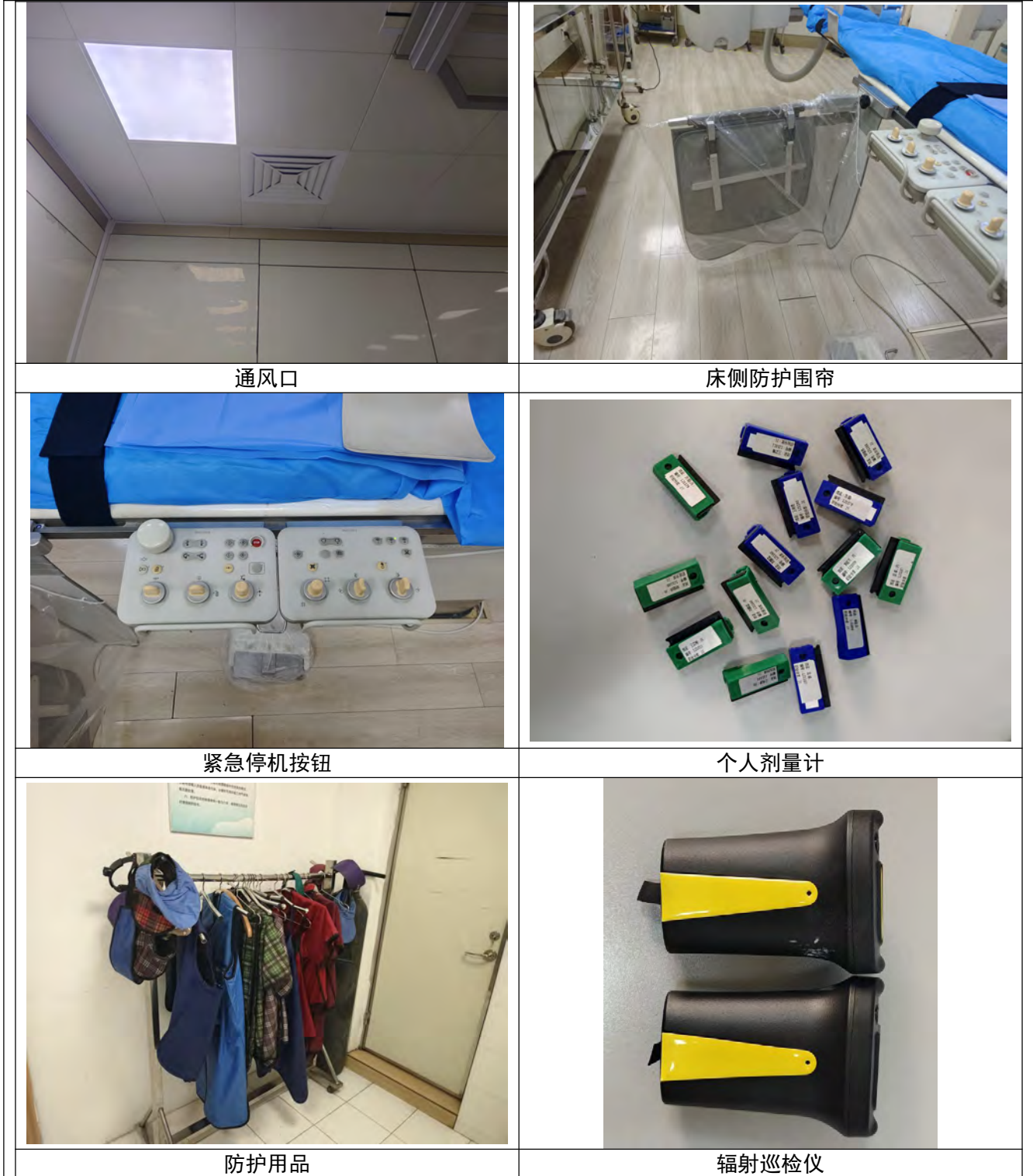
图 3-2 DSA 装置机房辐射安全与防护措施现场照片
