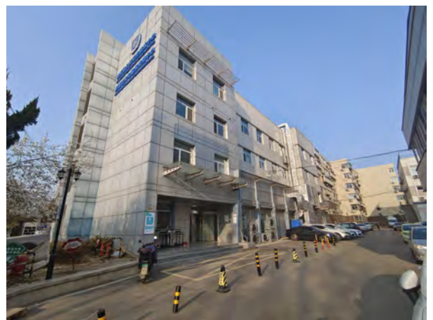
北侧检验中心
