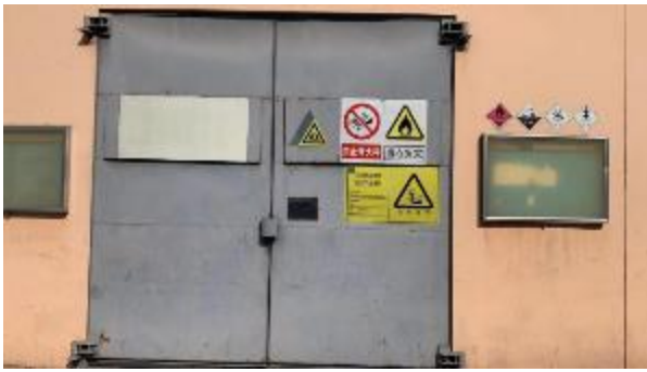
5. 依托厂内危废暂存间
