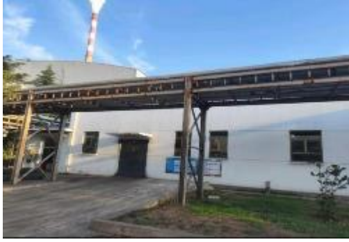
电缆线路南侧 5m #2 燃煤转运站
