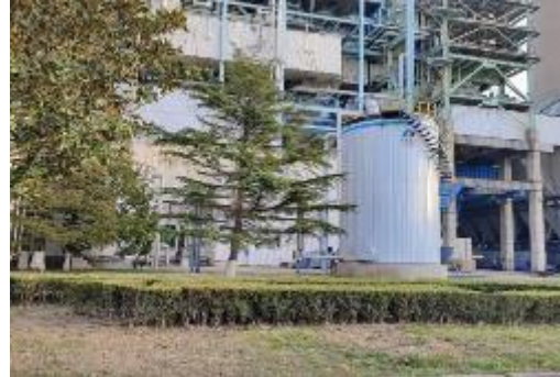
6. 电缆沟上方恢复情况
