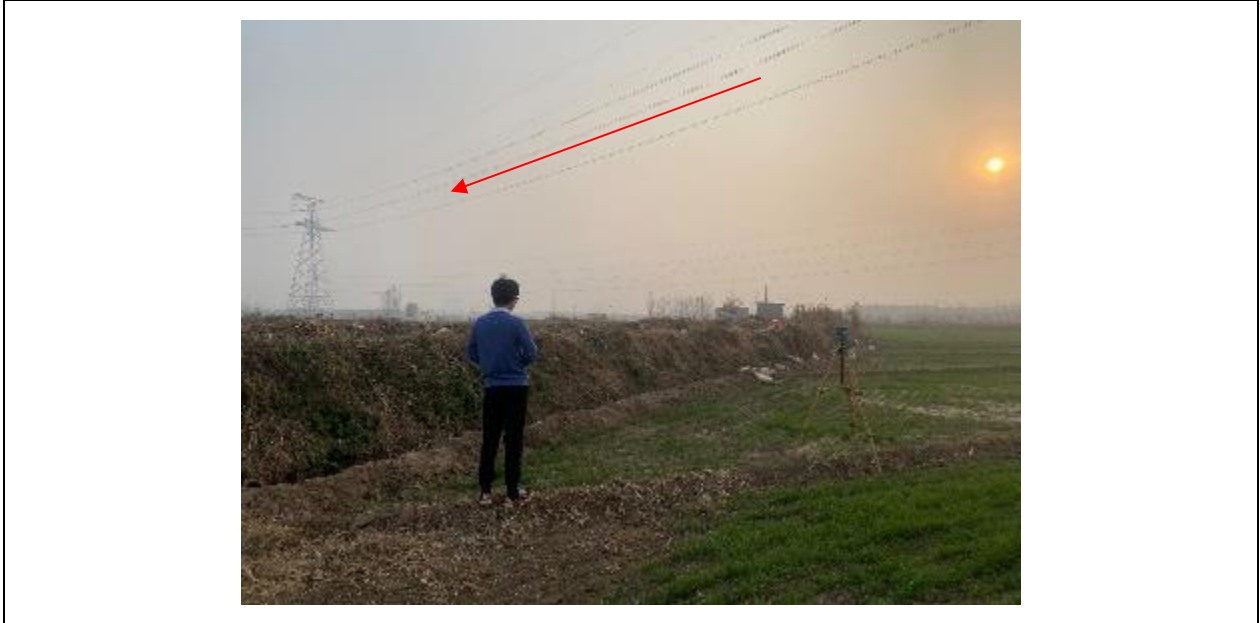
图4-1 220kV输电线路周围现场照片（拍摄于2023年11月）
