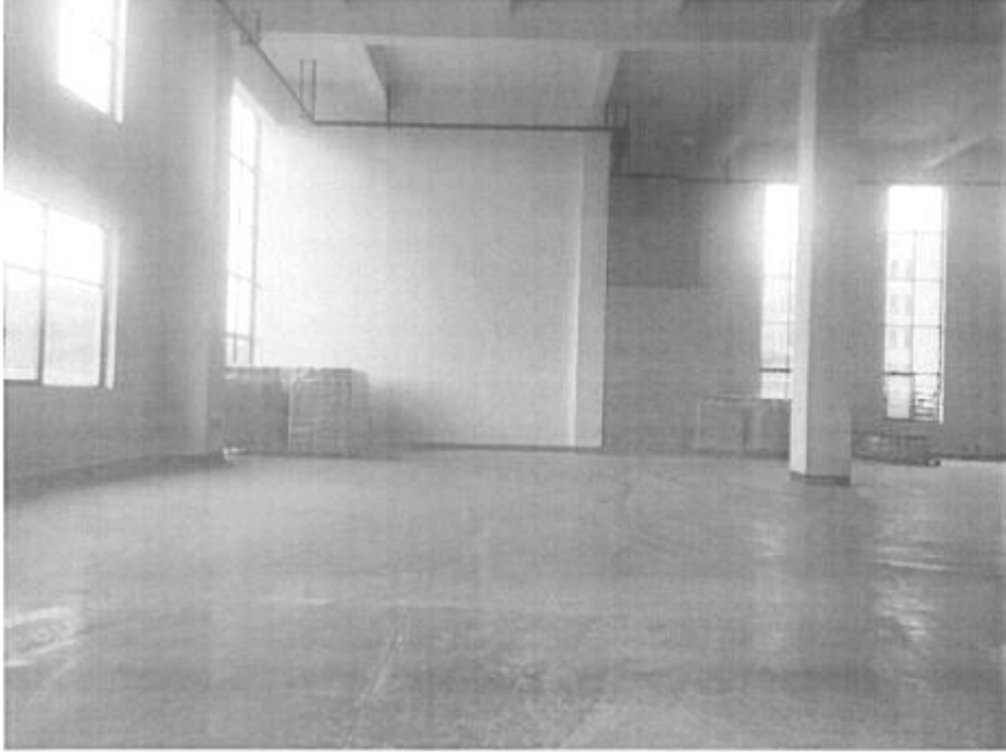
图 2 现场检测照片
