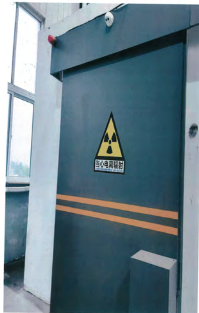
门机连锁装置失灵，开机工作状态下小铅门警示灯指示红灯不亮
