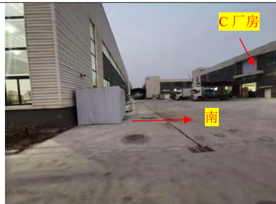
曝光室南侧（厂区内道路、C 厂房）
