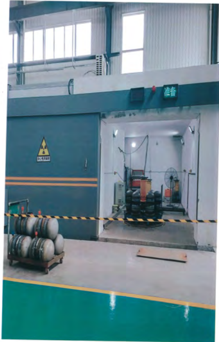
设备关机正常，大铅门关机状态下警示灯指示绿灯亮
