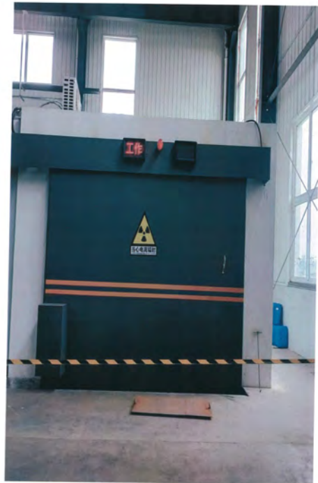
设备开机工作正常，大铅门工作状态下警示灯指示红灯亮
