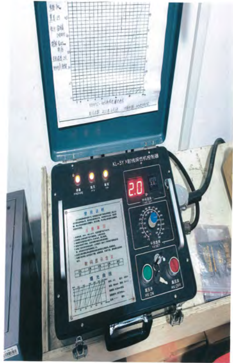
检修完毕设备开机工作正常
