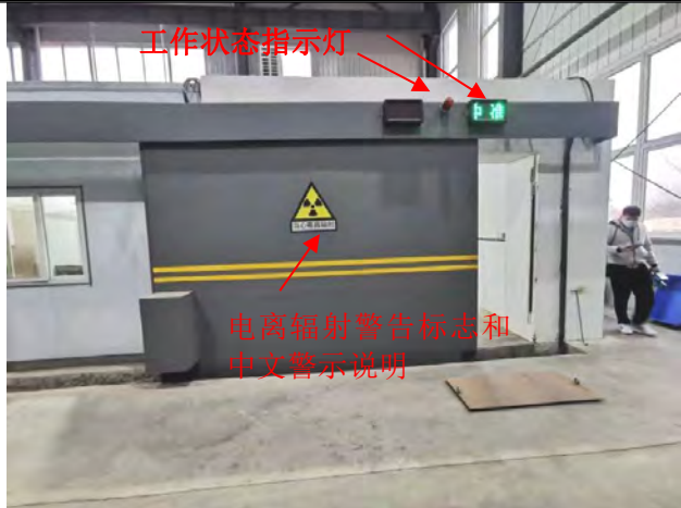
北侧防护门外
