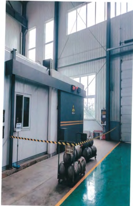
现场拉起警戒线，禁止无关人员进入
