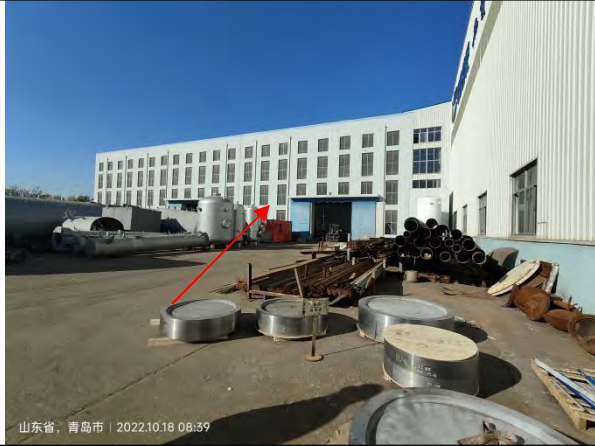
曝光室南侧 5m 厂区 3#车间
