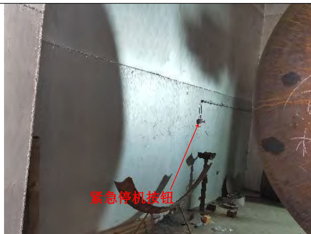
曝光室内东墙紧急停机按钮
