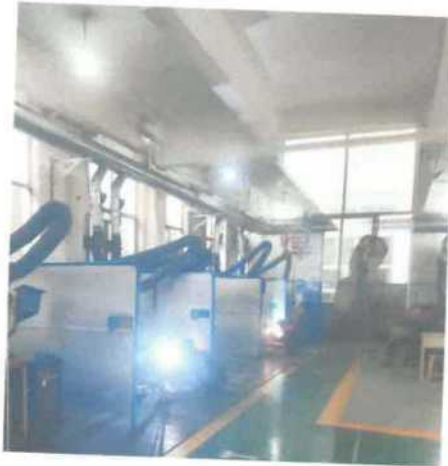
项目现场照片
