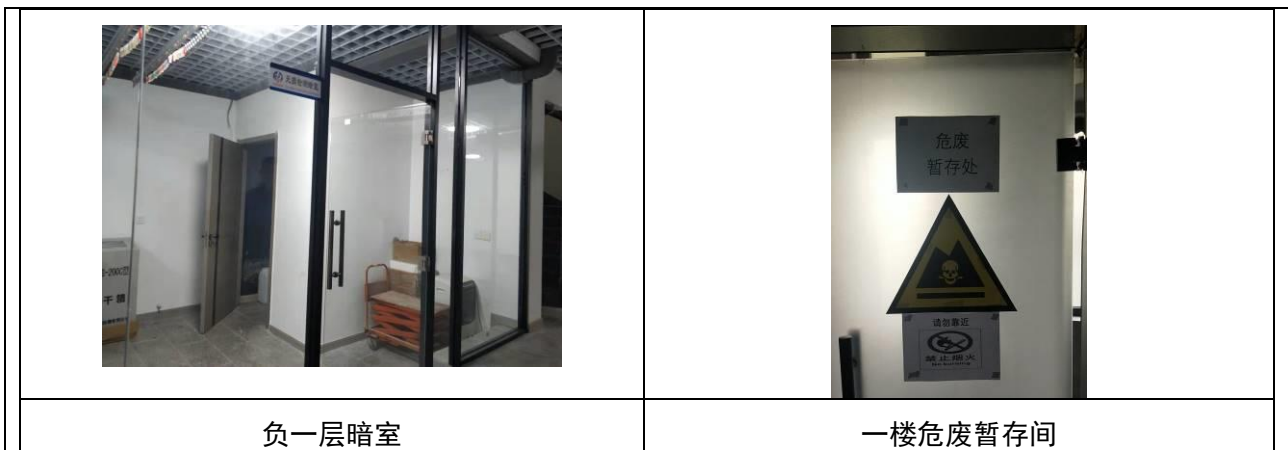
图 4-4 本项目现场照片（拍摄于 2021 年 5 月）
